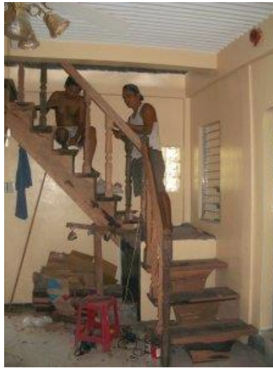
Treppe hinauf in den 2. Stock
