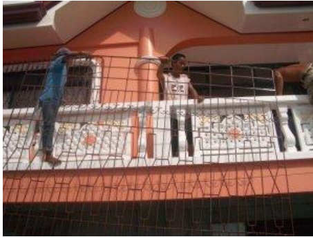
Allan montiert das Fenstergitter der Terasse
