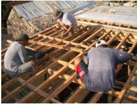
...und auf einem Holzger st das Wellblech montiert
