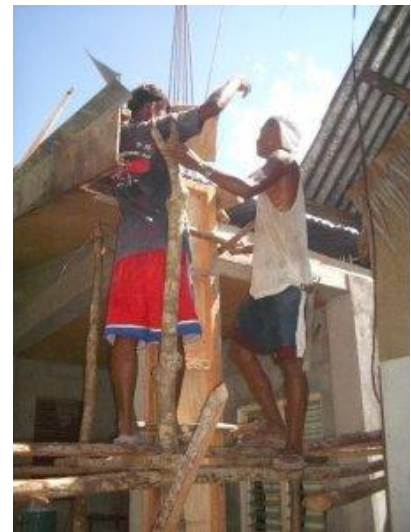
Zuerst müssen die Stützpfiler auf Küchenseite erstellt werden
