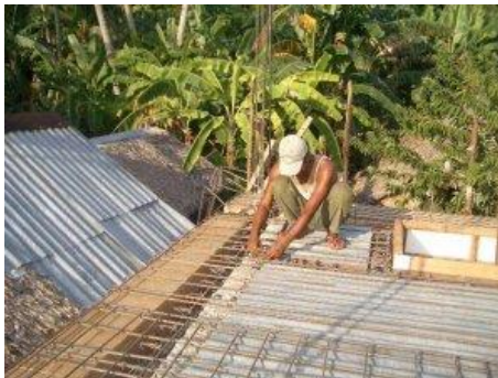
...dar ber wird ein Eisengitter gelegt und verschweisst
