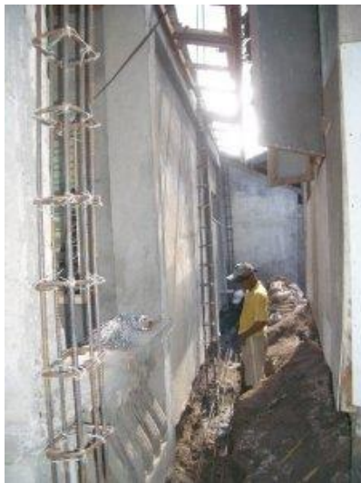
Zuerst müssen die Stützpfiler auf Küchenseite erstellt werden
