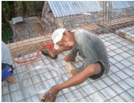
Bevor mit dem Betonieren begonnen werden kann, muss Elektriker Major die Kabel setzen
