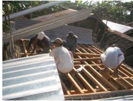
...und auf einem Holzger st das Wellblech montiert
