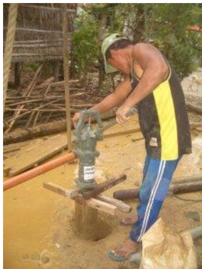
in sechs Meter Tiefe ist er erfolgreich
