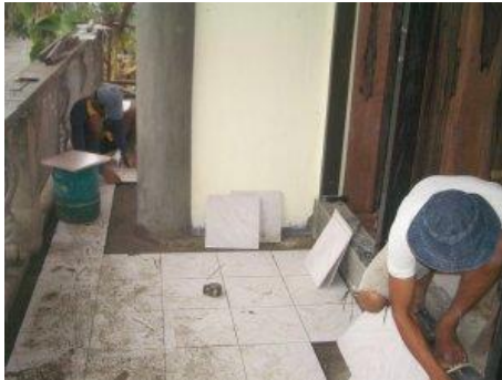
Die Terrasse wird geplättelt
