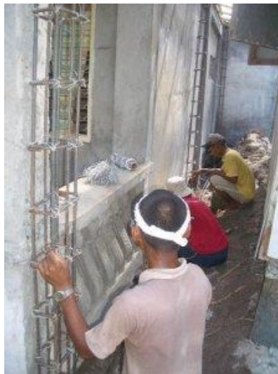
Zuerst müssen die Stützpfiler auf Küchenseite erstellt werden
