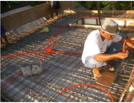
Bevor mit dem Betonieren begonnen werden kann, muss Elektriker Major die Kabel setzen
