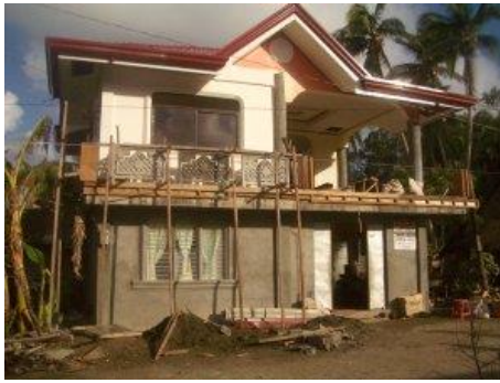
Die Balustrade aus Beton wird aufgesetzt
