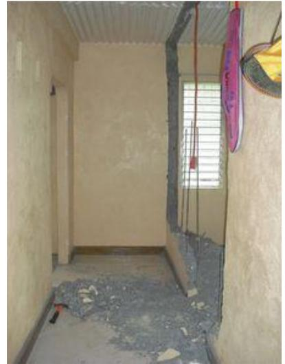
...und die Türe zum Korridor zugemauert - Bild rechts: Die Mauer des Kinderzimmers wird ebenfalls herausgerissen
